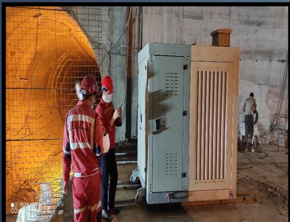
نصب تجهیزات پست LPS
